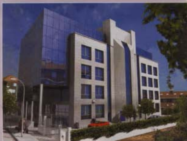
Edificio de la nuevas oficinas de los Laboratorios Juste en Madrid.
